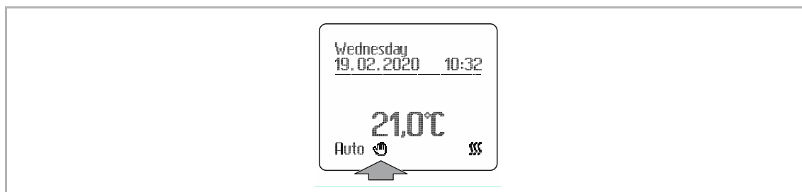
Fig. 14: Provozní mód: AUTO s ručně upravenou hodnotou teploty
