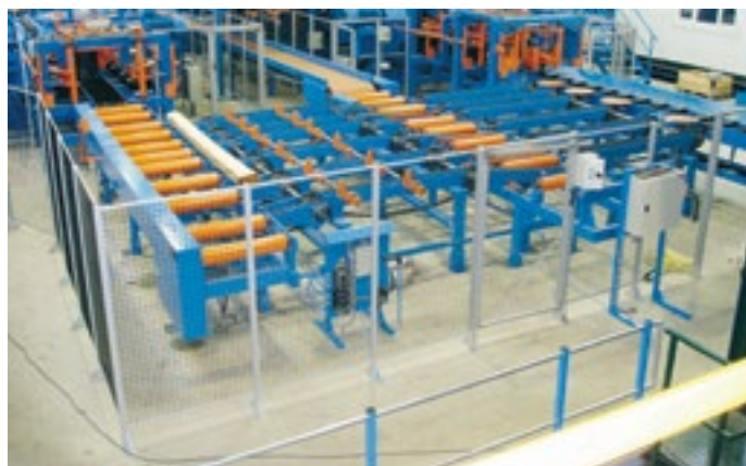
Sestavení na místě.
